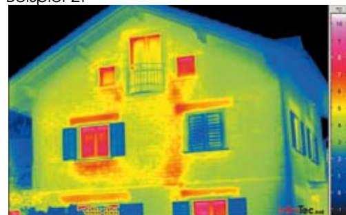
Wärmebrücken an der Fassade
