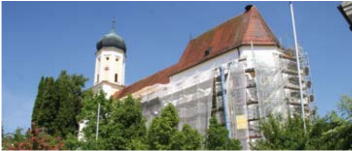
Bis zum Abschluss der Dachsanierung präsentiert sich die Burgheimer Kirche ringsum „gut gerüstet“.
