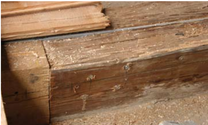
Gut erkennbar: Die integrierte Stahlplatte
