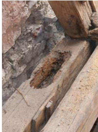
Solche Balken können nichts mehr tragen.
