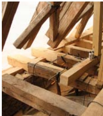
„Operation am offenen Dach“
