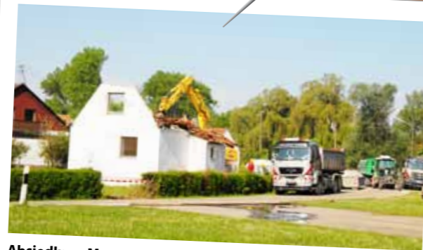
Absiedlung Moos Im Zuge der Absiedlung wurde in Moos ein weiteres Wohnhaus abgebrochen.
