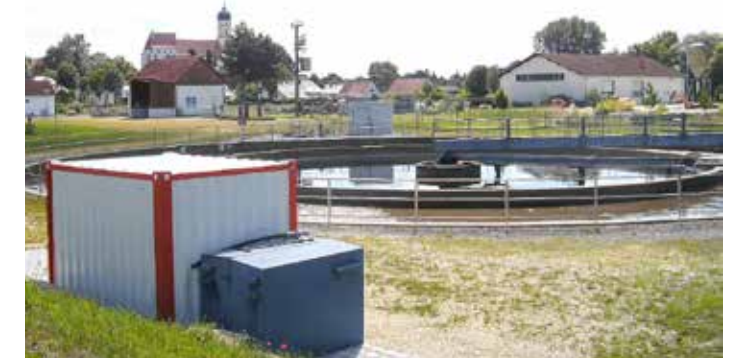
Studentisches Untersuchungsobjekt Kläranlage Burgheim.
