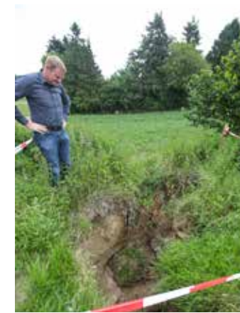
GR Manfred Meier (Biding) besichtigt eine Schadensstelle an einem Feldrand.
